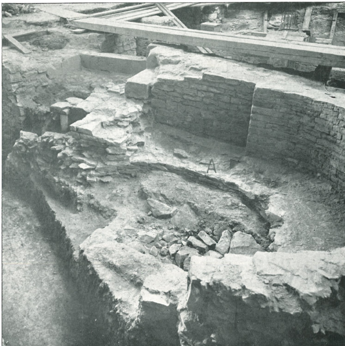
Václavova rotunda. Zbytek základu severní apsidy pod zdivem z XI. století.
