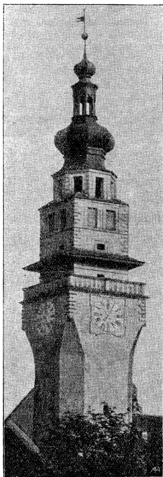
Boškovice: Věž radnice.
