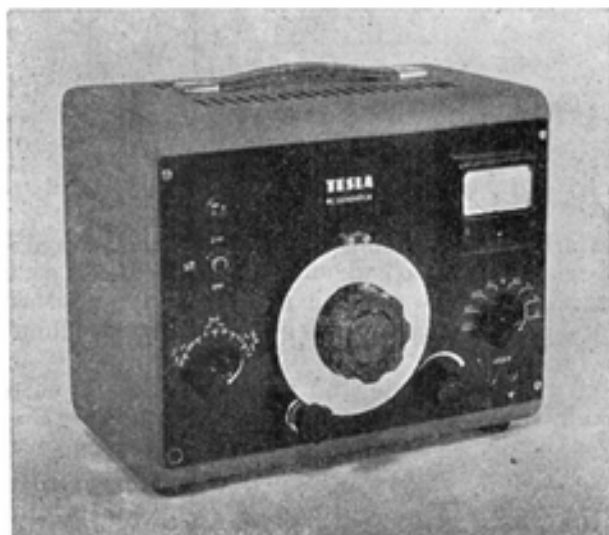
Obr. 47,6. Tónový generátor elektronkový Tesla pro kmitočty 20 Hz — 1,2 MHz.
