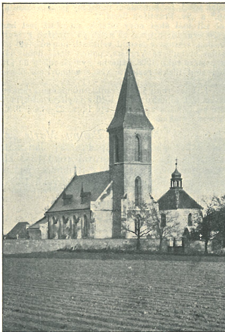
Kostel ve Velkém Pálči (se zvonící r. 1901 zbořenou).
