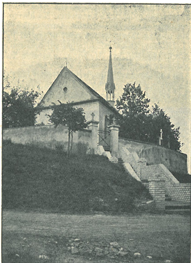
Filiální kostel v Lidicích (pohled od západu).
