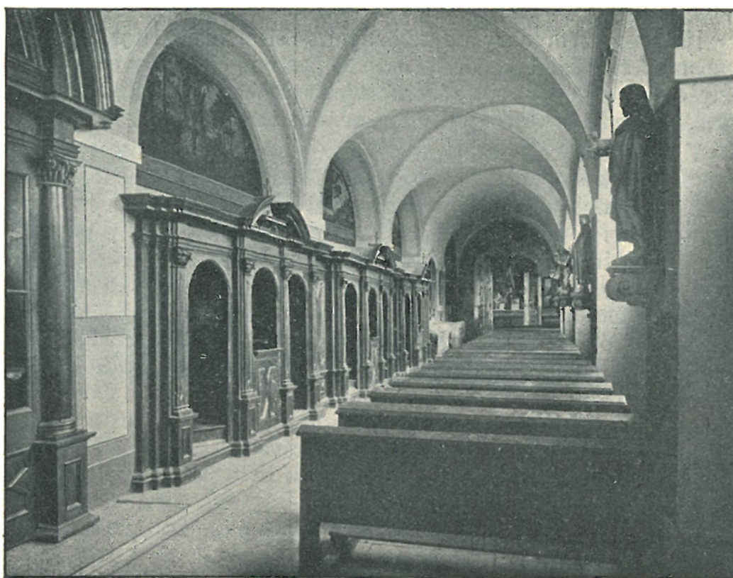
Pohled do jižního ambitu kláštera Hájeckého.
