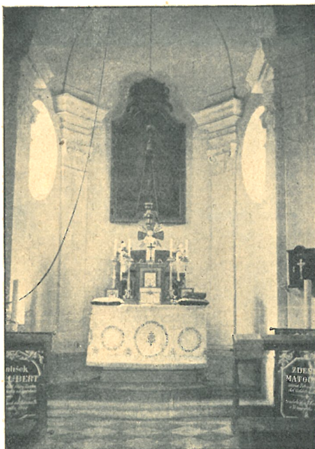
Vnitřek kaple sv. Isidora v Kovárech.
