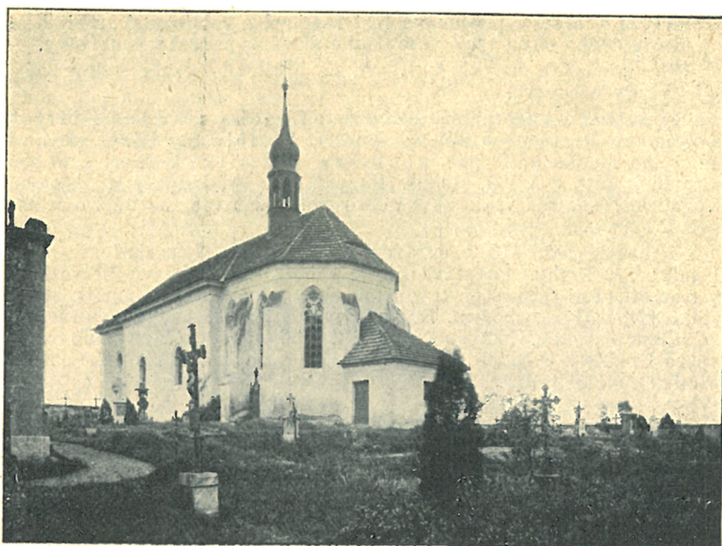
Kostel v Černovičkách před opravou.
