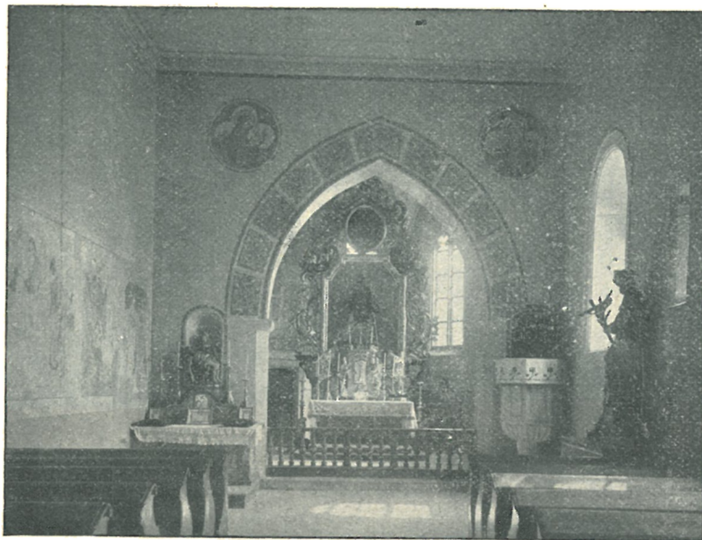
Vnitřek kostela v Černovičkách po opravě.
