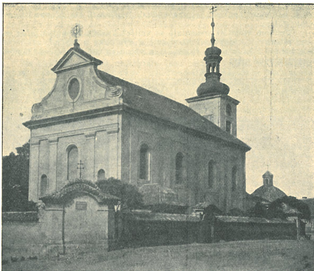
Farní kostel ve Středoklukách. Pohled se strany jihozápadní.
