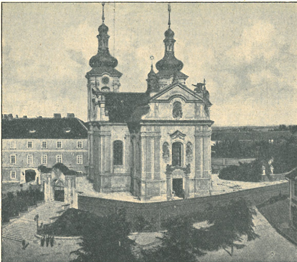
Farní kostel ve Zlonicích. (Pohled se strany severozápadní.)
