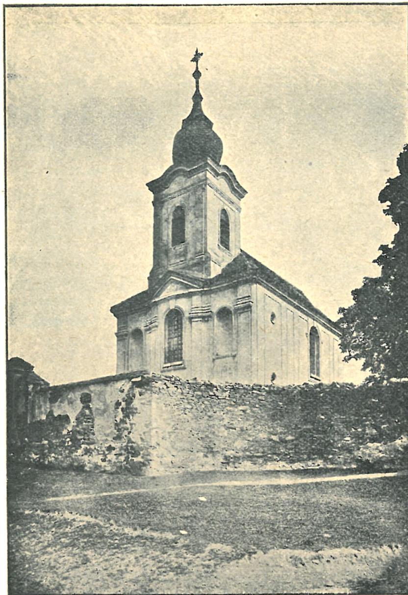
Kostel v Újezdě sv. Kříže.
