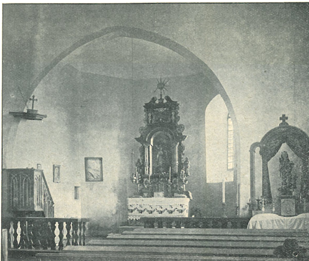
Vnitřek kostela v Chomli.
