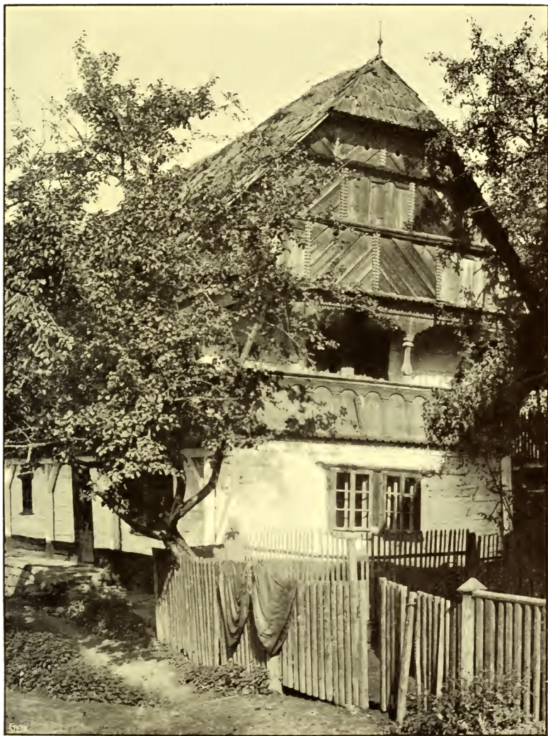
CHALUPA V MARKVARTICÍCH Č. 29 (U URBANČ)
