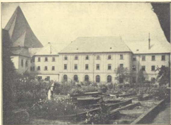
Zadní fasáda olomuckého dominikánského konventu. Nová administrace je přistavena mezi hlavní budovou a kostelem.
