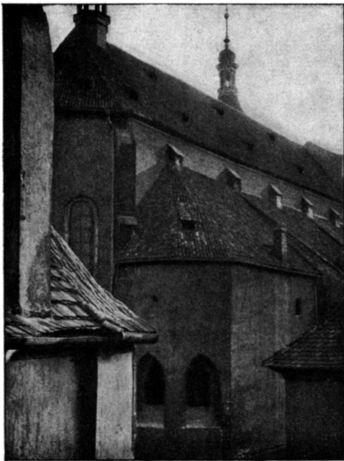
Kostel sv. Haštala se strany severovýchodní. (Vpředu zbytek původního chrámu.)
