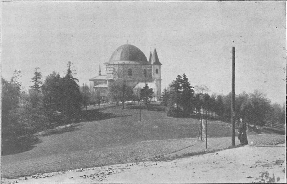
Severní část kostela se opravuje.
