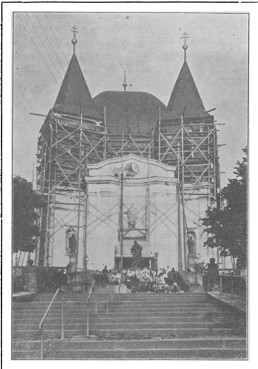
Chrám svatohostýnský při opravě průčelí a věží.
