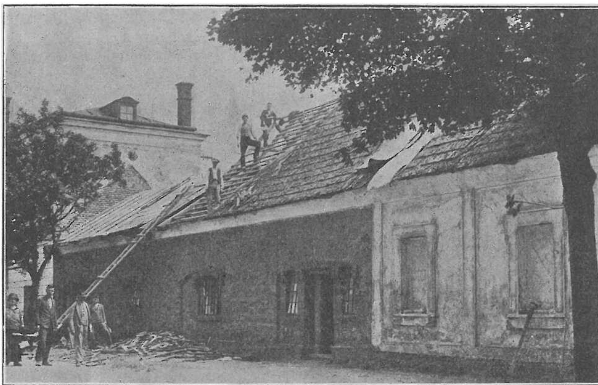
Oprava jižního ambitu po zažehnaném požáru.
