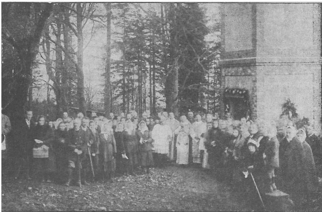
Pořsvěčení transformatoru. (Fotografovali Mr. Malzer a Fr. Oškera.)
