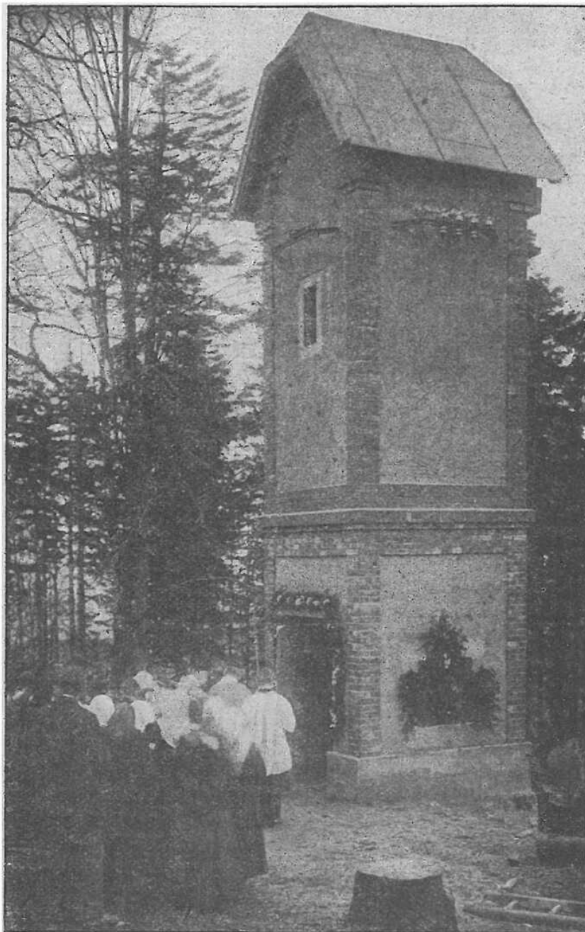
Svěcení elektrického transformatoru na Sv. Hostýně.
