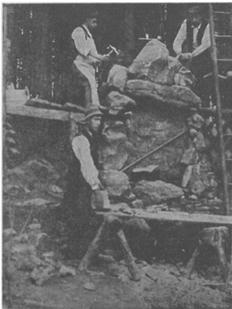
* Staví se podstavec z balvanů pro hřbitovní kříž na Sv. Hostýně.
