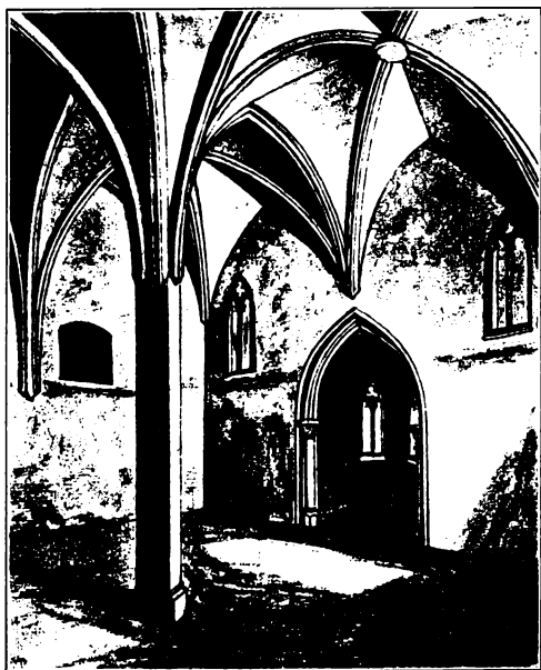
Vnitřek kaple sv. Cyrilla a Methoda před zbořením.
