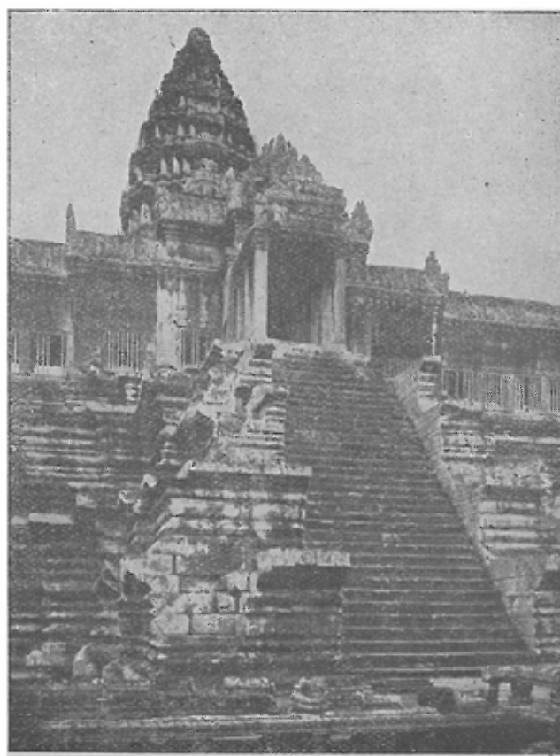
Angkor-Wat. Přední budova třetího poschodí.
