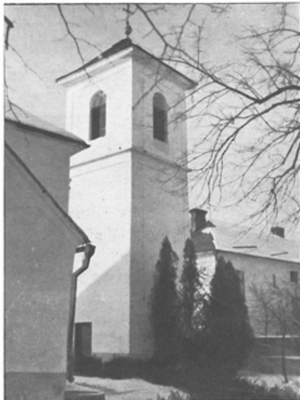
Věž farního kostela v Drahanovicích, zvaná „Campanilla“, opravena péčí státu a svépomocí věřícího lidu.
