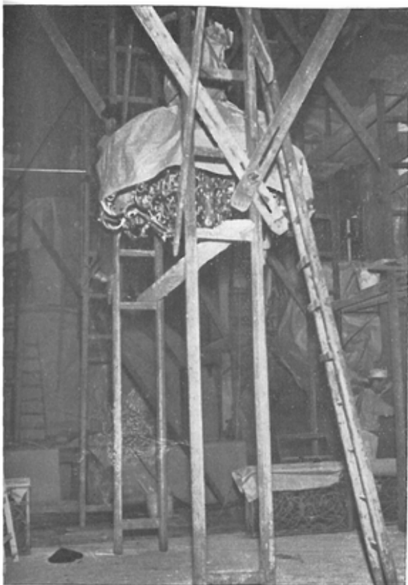
Ve dnech byla dokončena oprava vnitřku děkanského kostela v Zbraslavi nad Vltavou. Stát uhradil 230.000.— Kčs.
