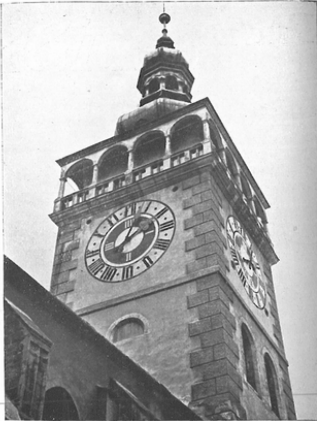
Pohled na věž kostela sv. Václava v Mikulově, který byl právě opraven péčí našeho státu.
