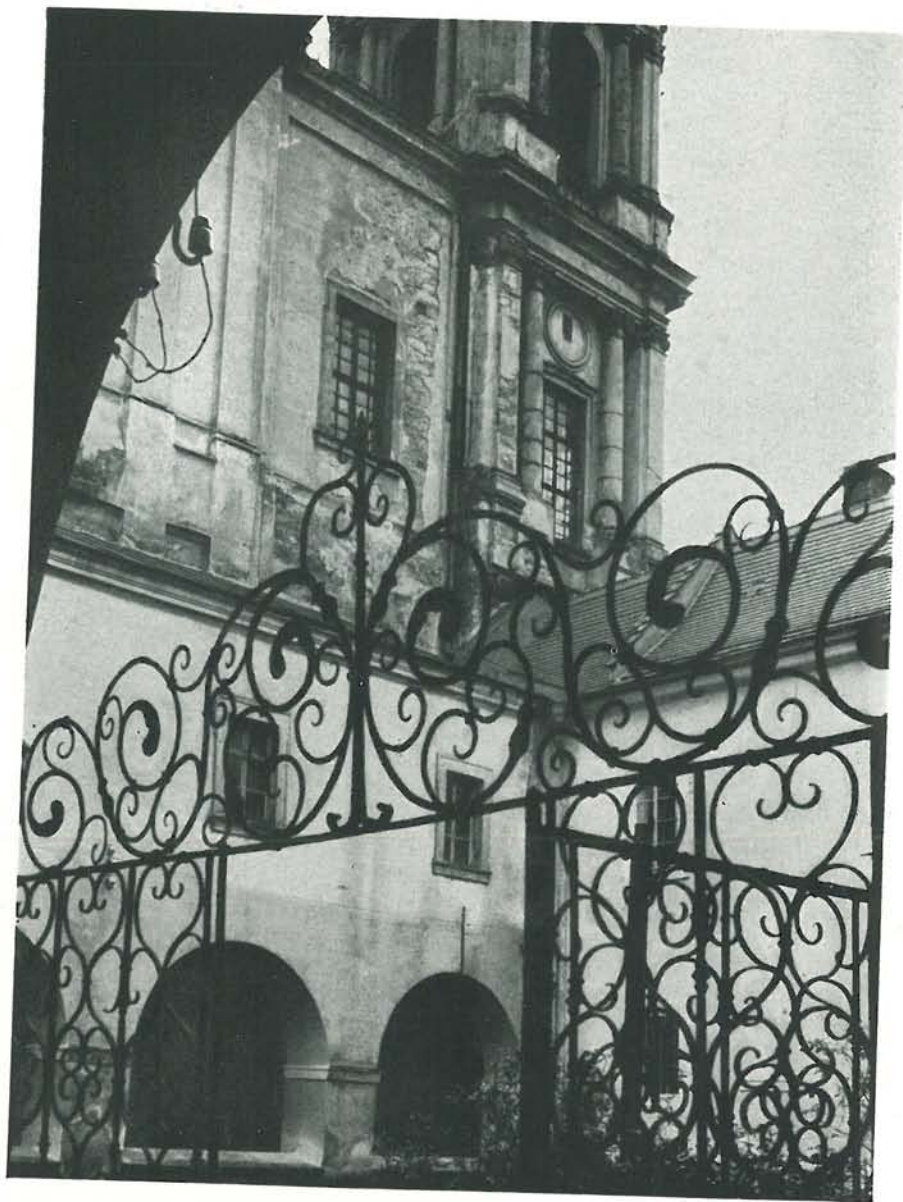
8. Kostel sv. Vavřince v Jablonném. Pohled z klášterního ambitu.
