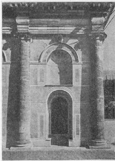
Západní nároží po skončení stavební obnovy a před restaurací sgrafit 1952
