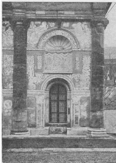
Západní nároží po obnově sgrafit 1952
