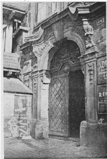
Portál domu čp. 550-I
