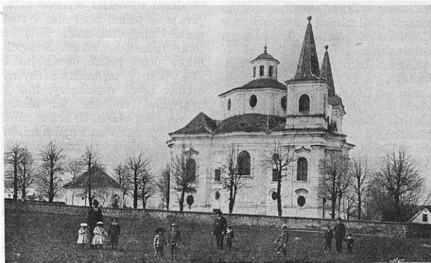
2. Kostel v Nicově s prozatímními střechami věží po poškození vichřicí v r. 1870.
