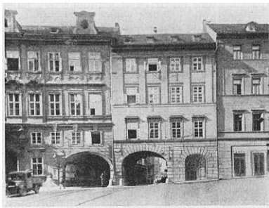
Obr. 1. Vyústění s obloukovým nadpražím (nevhodné).
