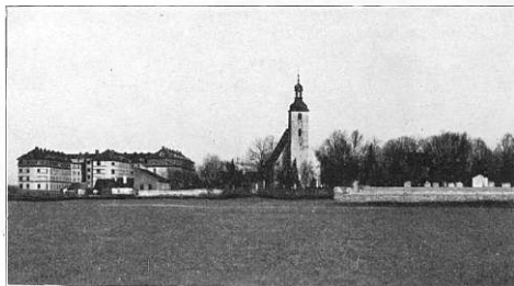
Obr. 40. Pohled na hřbitovní kostel sv. Prokopa a Jana Křtitele na Starém městě v Č. Budějovicích.
