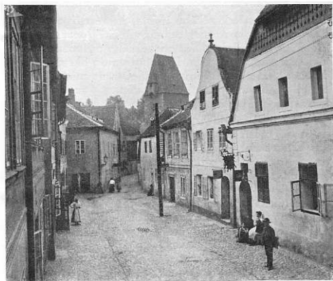
Obr. 26. Č. Budějovice. Panská ulice. Platná regulační čára narovnávala uliční zákrut a před věží, již rovněž nešetřil, vytvářuje náměstíčko. V popředí dům čp. 61, nyní hrubě adaptovaný (srv. obr. č. 46).
