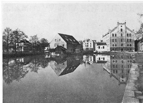
Obr. 33. Č. Budějovice. Vltava pod klášterem před říční úpravou.
