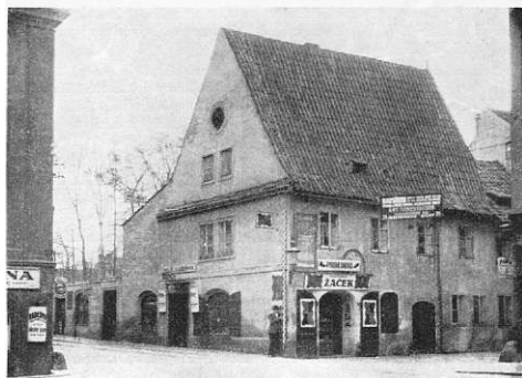
Obr. 44. Č. Budějovice. Krajinská třída. Dům čp. 129/130 s malebnou prejzovou střechou, zbytek býv. Pražské brány, ustoupil r. 1927 novostavbě.
