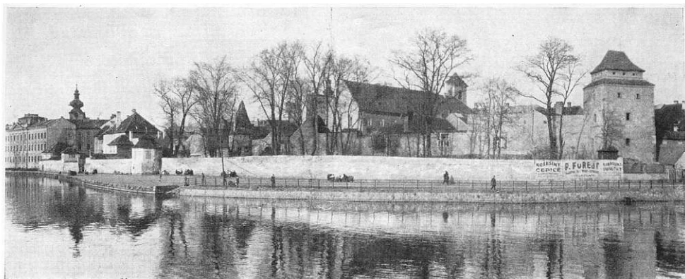
Obr. 29. Č. Budějovice. Pohled s Krumlovských alejí na dvojitý hradební pás vnitřního města s biskupskou zahradou, Otakarovou baštou a hradební věží — obraz, který by byl úplně zničen provedením nynějšího regulačního plánu.
