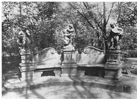
Obr. 52. Dienzenhoferovy sošky, jichž bylo kdysi použito jako stavebního materiálu ke stavbě zahrádní zdi v minulém století zbourané.
