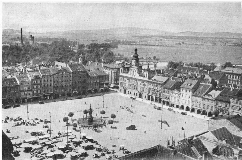
Obr. 36. Č. Budějovice. Pohled s Černé věže směrem k radnici. V pozadí Klet', před ní Dlouhá louka. Novostavba u radnice budova Fénixu.
