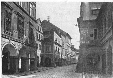
Obr. 25. Č. Budějovice. Česká ulice, pohled od severu. V popředí Knappův dům z r. 1806. Platná regulační čára odstraňuje loubí vůbec.
