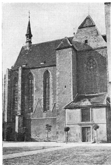
Čes. Budějovice. Klášterní kostel od severu před opravou. (Zapůjčeno Kruhem pro pěstování dějin umění.)
