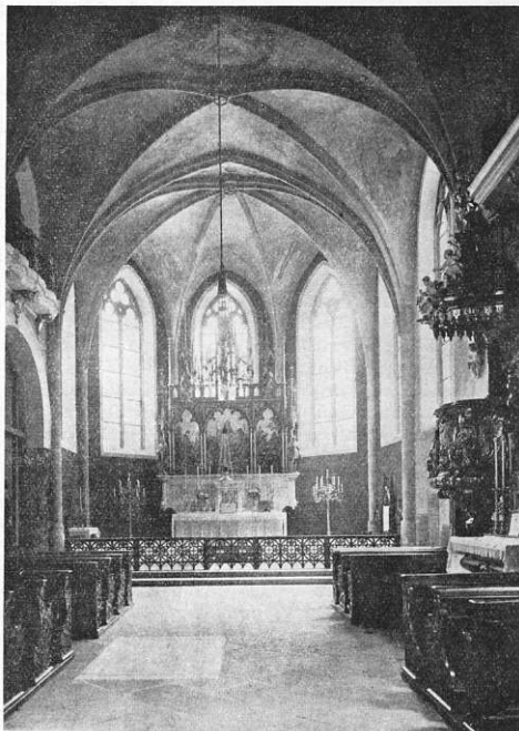
Kostel sv. Vojtěcha. Presbytář po renovaci.
