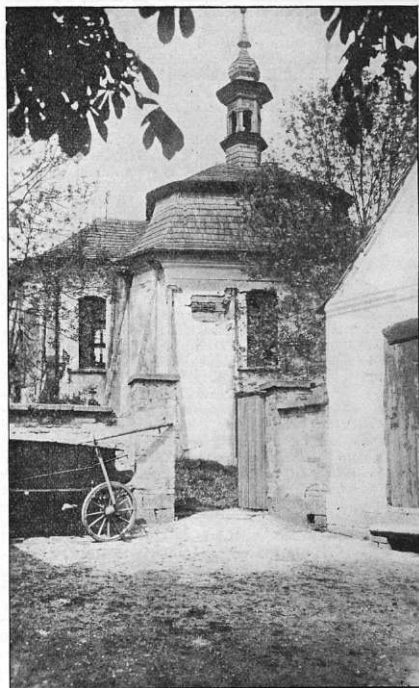
Loučná Hora u Nového Bydžova, filiální kostel.
