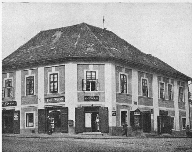
Obr. 3. Dům čp. 409 na nároží ulice Tylovy a Palackého náměstí. Dobře udržovaný.
