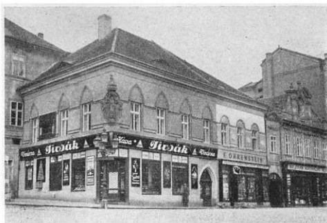
Obr. 6. Tentýž dům po nešťastné úpravě v r. 1925.
