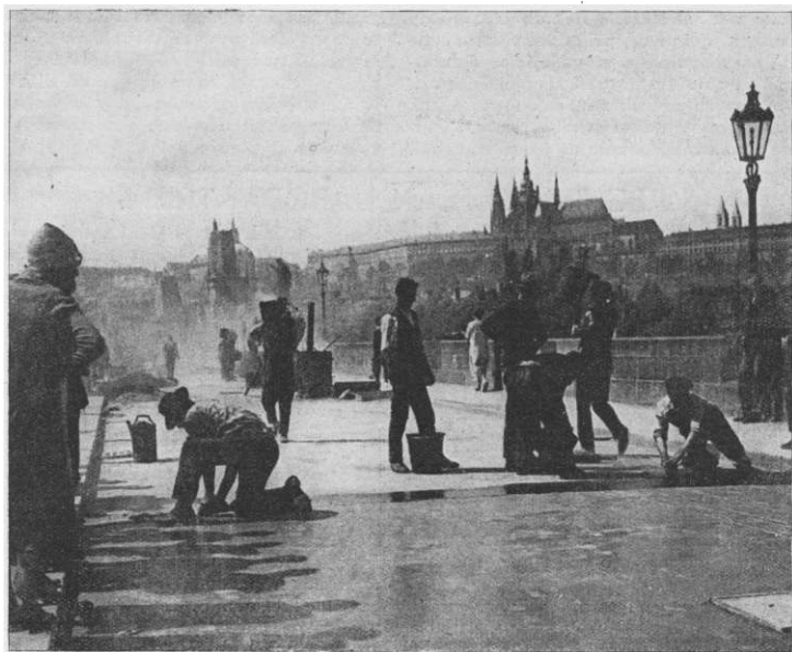
Asfaltování Kamenného mostu v Praze.
