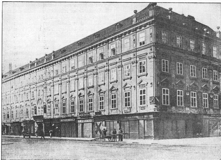
Dům čp. 36-II. v Jungmannově třídě v Praze, bývalý palác Thunovský. Stav po přístavbě třetího patra v letech šedesátých XIX. století. Zbořeno roku 1922 a 1923. Zničeno bylo i mohutné empírové schodiště, ač bylo slibeno jeho zachování. Na místě paláce vybudovala svou budovu Riunione Adriatica di Sicurtà z Terstu podle návrhů arch. P. Janáška (fasáda) a arch. Zasche (vnitřní dispozice a výzdoba). Foto Zikmund Reich, Praha.
