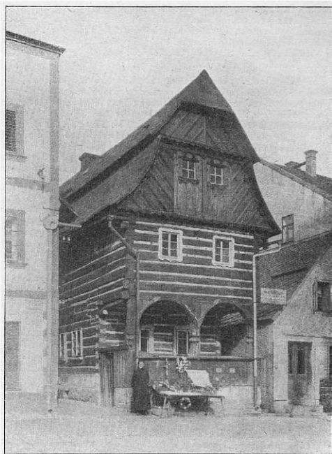
Ohrožený dřevěný šitýv dům městský s přízemní arkádou v Železném Brodě, jehož záchrana jest kulturní povinností celé naší veřejnosti.
