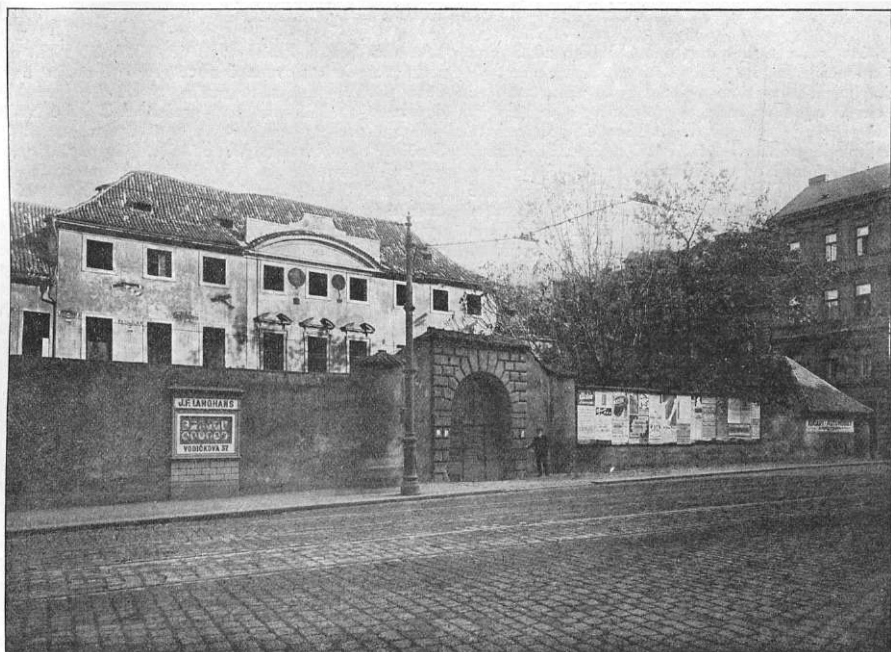
Michnovův palác na Újezdě. Průčelní fasáda do ulice s ohradní zdí a branou.
