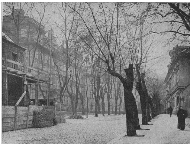
Obr. 10. Nový přístavek domu čp. 490/III.,
