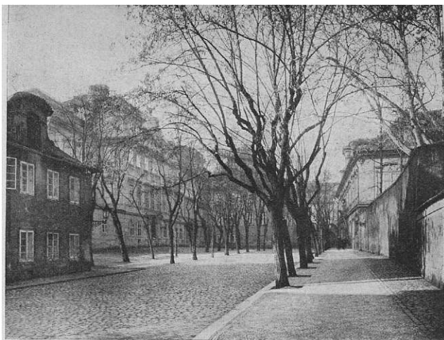
Obr. 9. Přístavek domu čp. 490/III. před zbořením.
