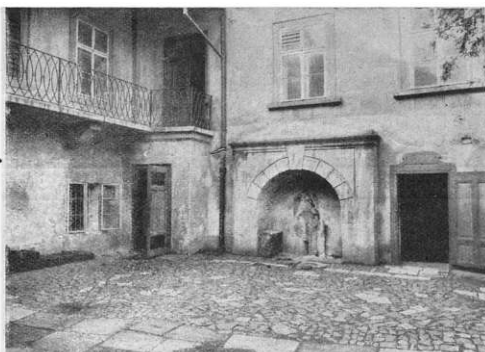
Obr. 88. Dům čp. 791-II. Zadní dvůr s bývalou kašnou.
