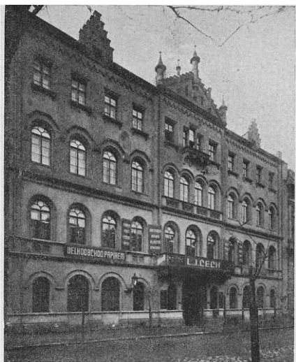
Obr. 67. Průčelí domu čp. 628-II.
