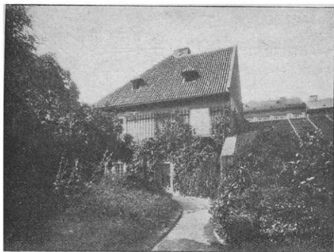
Obr. 78. Hospodářská budova v býv. bot. zahradě.
