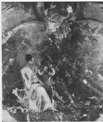
Obr. 86. J. Navrátil, jaro. Detail z výzdoby stropu ve věži u domu čp. 791-II.
