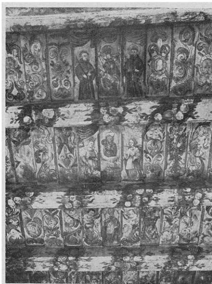
Obr. 48. Dřevěný, malovaný strop, objevený při boření domu čp. 791-I.
