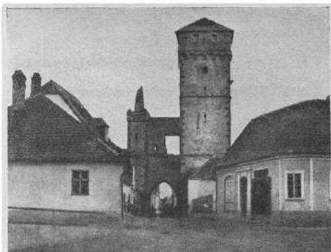
Obr. 117. Pražská brána ve Vys. Mýtě. Pohled zevni.
