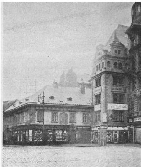
Obr. 4. Nynější stav ukazuje znehodnocení památky a renaissančení architektury činovním domem.
