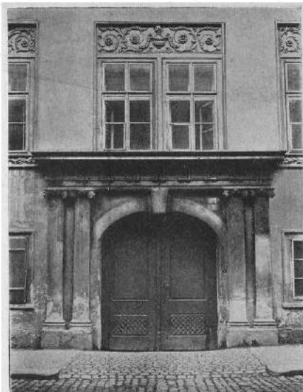
Obr. 31. Dům čp. 970-II. v Pájčovní ulici. Detail fačády: portál a sdružené okno.
