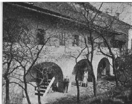
Obr. 56. Zadní průčelí bečovárny s pavlačí.
