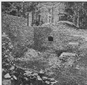
Obr. 56. Vnitřek veliké věže před odkopávkou rumu a hlíny. (Fot. 1909.)
