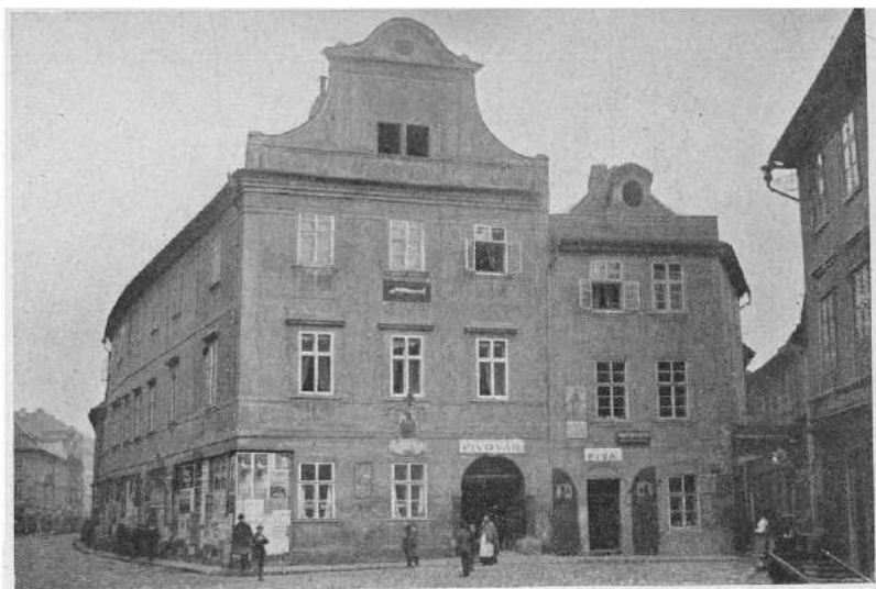
Obr. 52. Průčelí a fačáda postranní domu „U zlaté štiky“ v Dlouhé třídě.
