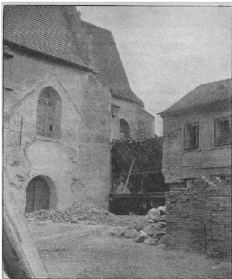
Obr. 44. Po zboření barokní kaple objevilo se původní okno do lodí a vedle něho schodiště na liter. kruchtu. Vzdálenost domku (původně ke kapli přilehlého) od nároží lodí udává přípustnou šíři komunikace vedle kostela.
