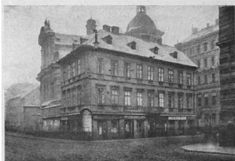
Obr. 2. Pohled opačným směrem ukazuje dosavadní poměr nárožního domu ke kostelu, celkem příznivý.
