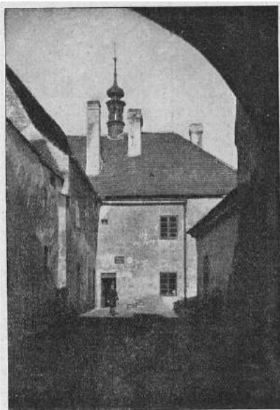
Obr. 33. Správně opravená vížka na staré škole v Pelhřimově.
