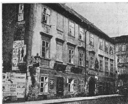
Obr. 97. Dům čp. 971-II. v Růžové ulici, rodný dům Fügnerův, zbořený 1912.
