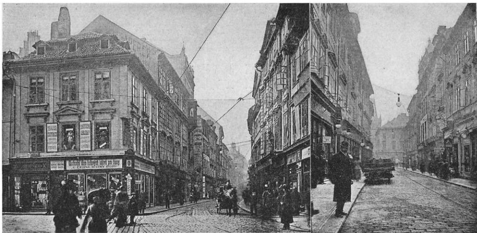
OBR. 33.—34. VHDNÉ UZAVŘENÍ POHLEDU DO CELETNÉ ULICE (V OBOU SMĚRECH) DOMEM „U ČERNÉ MATKY BOŽÍ“.
