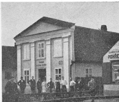
OBR. 56. EMPIROVÝ DOMEK V NOVÝCH HOLICÍCH, NEDÁVNO ZBOŘENÝ.
