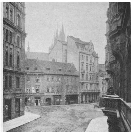
OBR. 47. TÝŽ POHLED PO ZBUDOVÁNÍ NOVÉHO DOMU ČINŽOVNÍHO NA MÍSTĚ DVOU STARÝCH DOMŮ.
