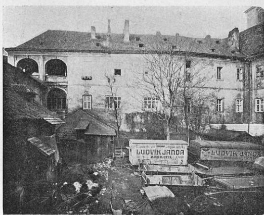
OBR. 20. VELIKÁ VZDUCHOVÁ PROSTORA V BLOKU ŠTUPARTOVA DOMU.
