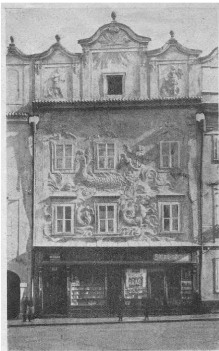
OBR. 74. ŠTUKOVÁ FAČÁDA DOMU „U JONÁŠE“ V PARDUBICÍCH. STAV PO RESTAURACI (MĚKČÍ FORMY, ZBAVENÉ NÁNOSU).
