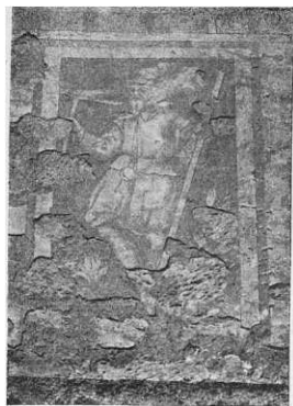
OBR. 65. SGRAFITA V NELAHOZE-VSI SV. HUBERTI (?) NA PŘÁVÉM RISALITĚ. STAV PŘED RESTAUR.
