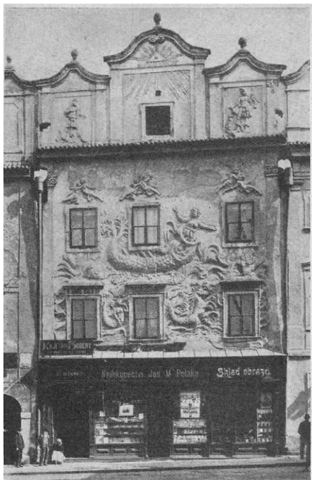
OBR. 73. ŠTUKOVÁ FAČÁDA DOMU „U JONÁŠE“ V PARDUBICÍCH. STAV PŘED RESTAURACÍ (FORMY ZHRUBELÉ NÁNOSY VÁPNA).
