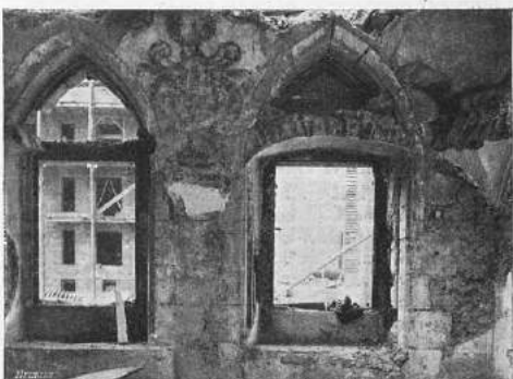
77. OKNA Z XV. STOLETÍ V SEV. STĚNĚ OBJEVENÉ GOTICKÉ MÍSTNOSTI. MEZI OKNY ZNAK VÁCL. Z HRADEŠÍNA Z XVI. ST.
