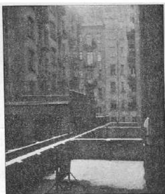
162. PŘÍKLAD ZASTAVĚNÍ Z ASSANACE-JOSEFOVSKÉ (DVORY PODOBNÉ ŠACHTÁM).
