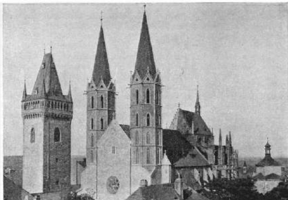
151. NYNĚJŠÍ STAV CHRÁMU SV. BARTOLOMĚJE V KOLÍNĚ, JEHOŽ PŮVODNÍ CHARAKTER BYL PŘESTAVBAMI A ZEJMÉNA POSLEDNÍ REKONSTRUKCÍ ZKAŽEN.
