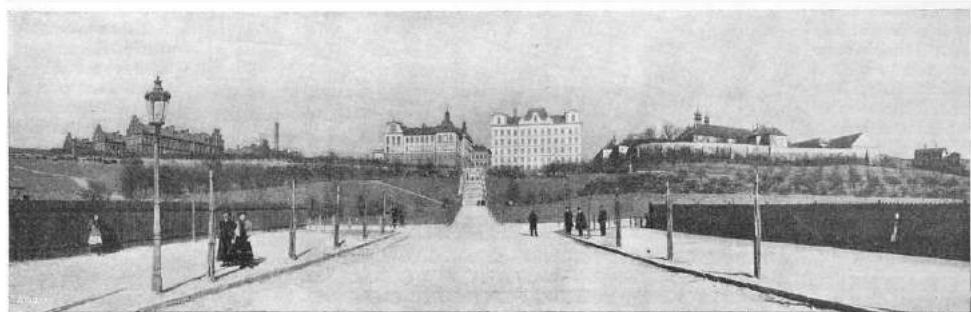
142. POHLED HLAVNÍ ULICÍ BUDOUCÍ UNIVERSITNÍ ČTVRTI KE SCHODIŠTI, RYZE PRAŽSKÉ MONUMENTALITY A K BUDOVAM ÚSTAVŮ UNIVERSITNÍCH, KTERÉ JSOU PROTIPŘÍKLADNĚ NESHARMONOVÁNY V CELEK.
