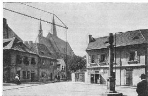
143. BUDOUCÍ REGULACE ZNIČÍ POSLEDNÍ DNEŠNÍ PĚKNÝ POHLED NA KOSTEL SV. APOLINÁŘE, KTERÝ ZA NOVÝMI DOMY ZMIZÍ.
