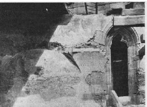
78. OKNO Z XV. STOLETÍ VE VÝCH. STĚNĚ OBJEVENÉ GOTICKÉ MÍSTNOSTI. NA STĚNĚ V LEVO STOPY MALEB Z XVI. ST.
