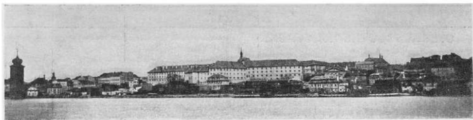
POHLED NA STARÝ STAV NOVOMĚSTSKÉHO BŘEHU PŘED STAVBOU PALACKÉHO NÁBŘEŽÍ.
