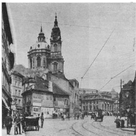
21. NYNĚJŠÍ STAV PRŮLOMU U KLÍČŮ, KTERÝM BYLY ZNÍČENY UZÁVŘENOST NÁMĚSTÍ I PŘEHLED KARMELOTSKÉ UL.
