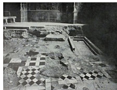
X. Pohled do svatováclavské kaple od jihozápadu po odkrytí staré dlažby Vpravo hrob sv. Václava s olověnou truhlou.
