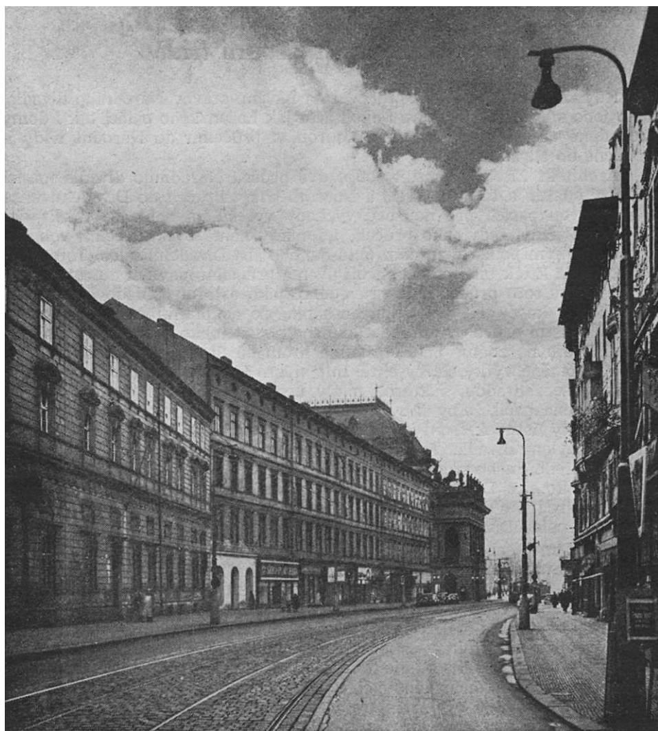
Nynější stav Kourových domů čp. 1369 a 1370 v Praze II u Národního divadla. — Foto arch. Miroslav Chalupníček.
