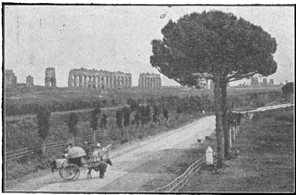
Cesta Appiova se zbytky vodovodů.
