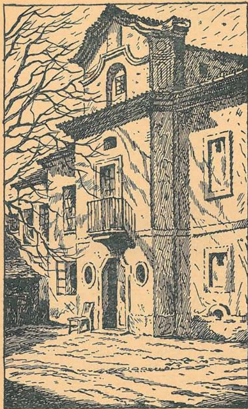
Dům ep. 79. Nový Svět. Nádvoří façada.
