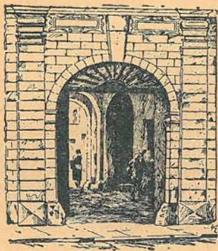
Dům čp. 436-I. Dominikánská ul.
