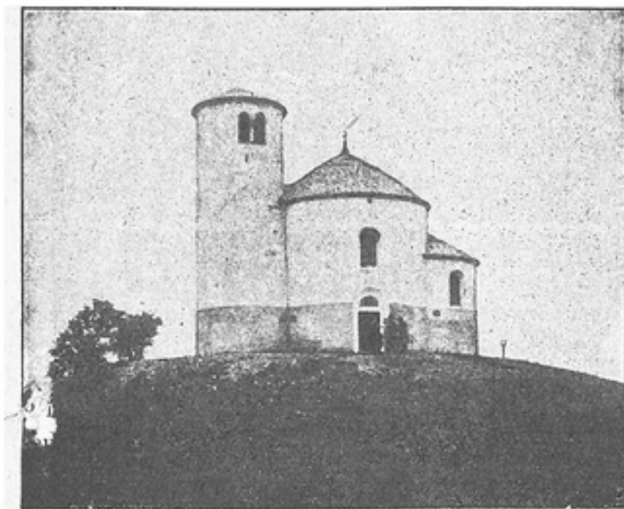
Obr. 32. Románská kaple na Řípu.
