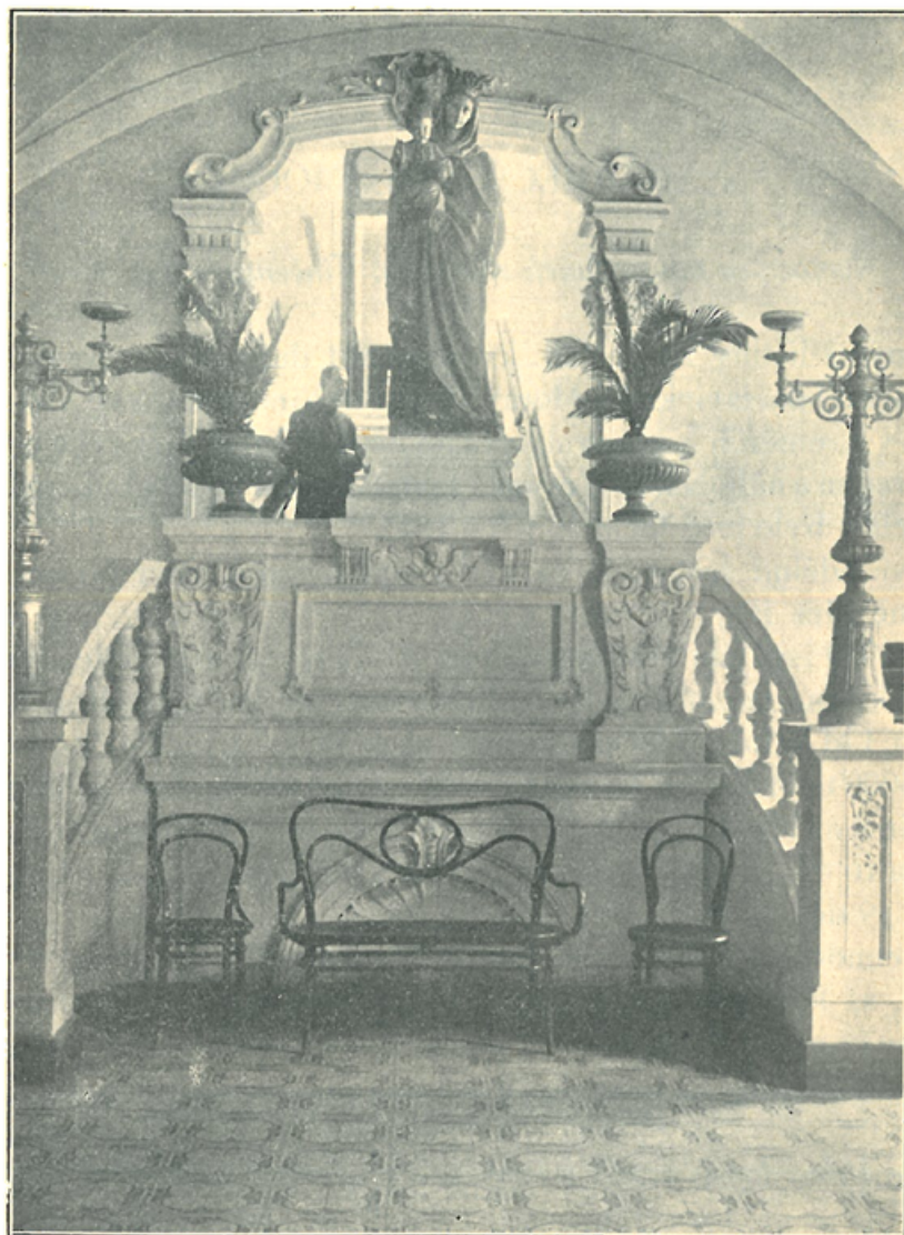
Schodiště kláštera (nemocnice) milosrdných bratří v Prostějově
