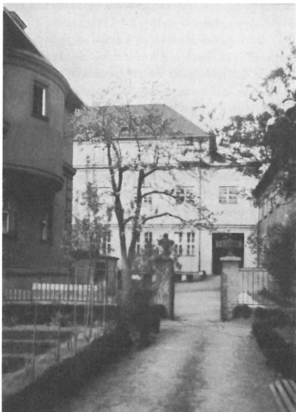
Kaple a příční křídlo nové nemocnice v Praze.
