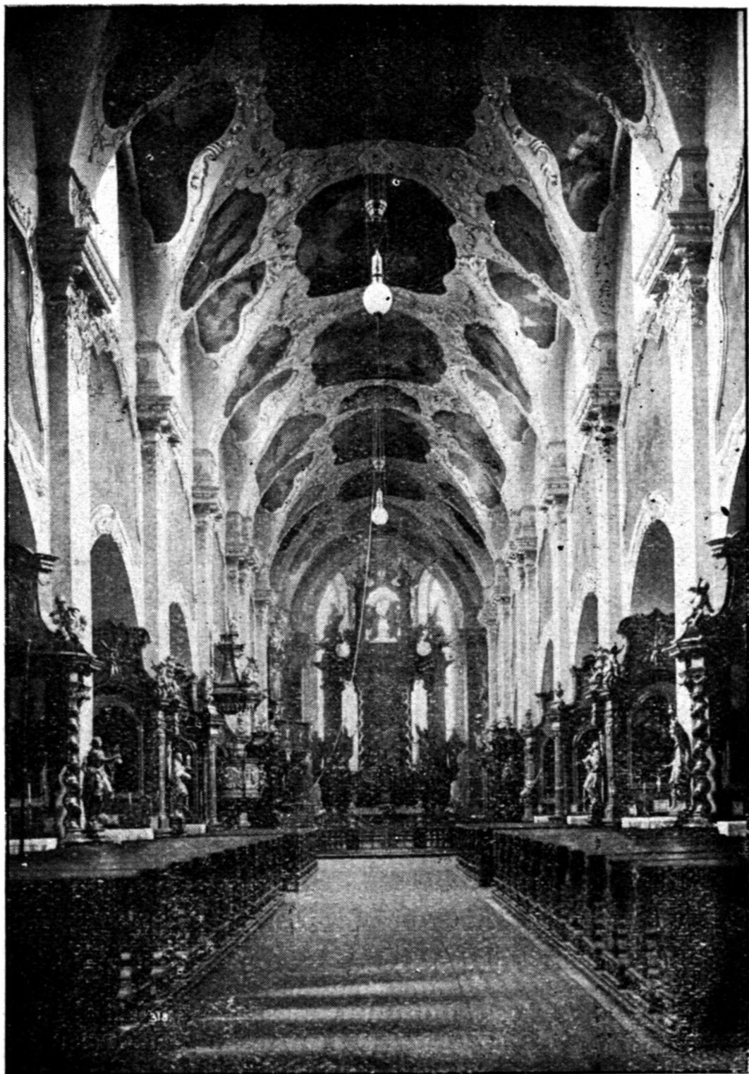
Vnitřek opatského chrámu na Strahově.
