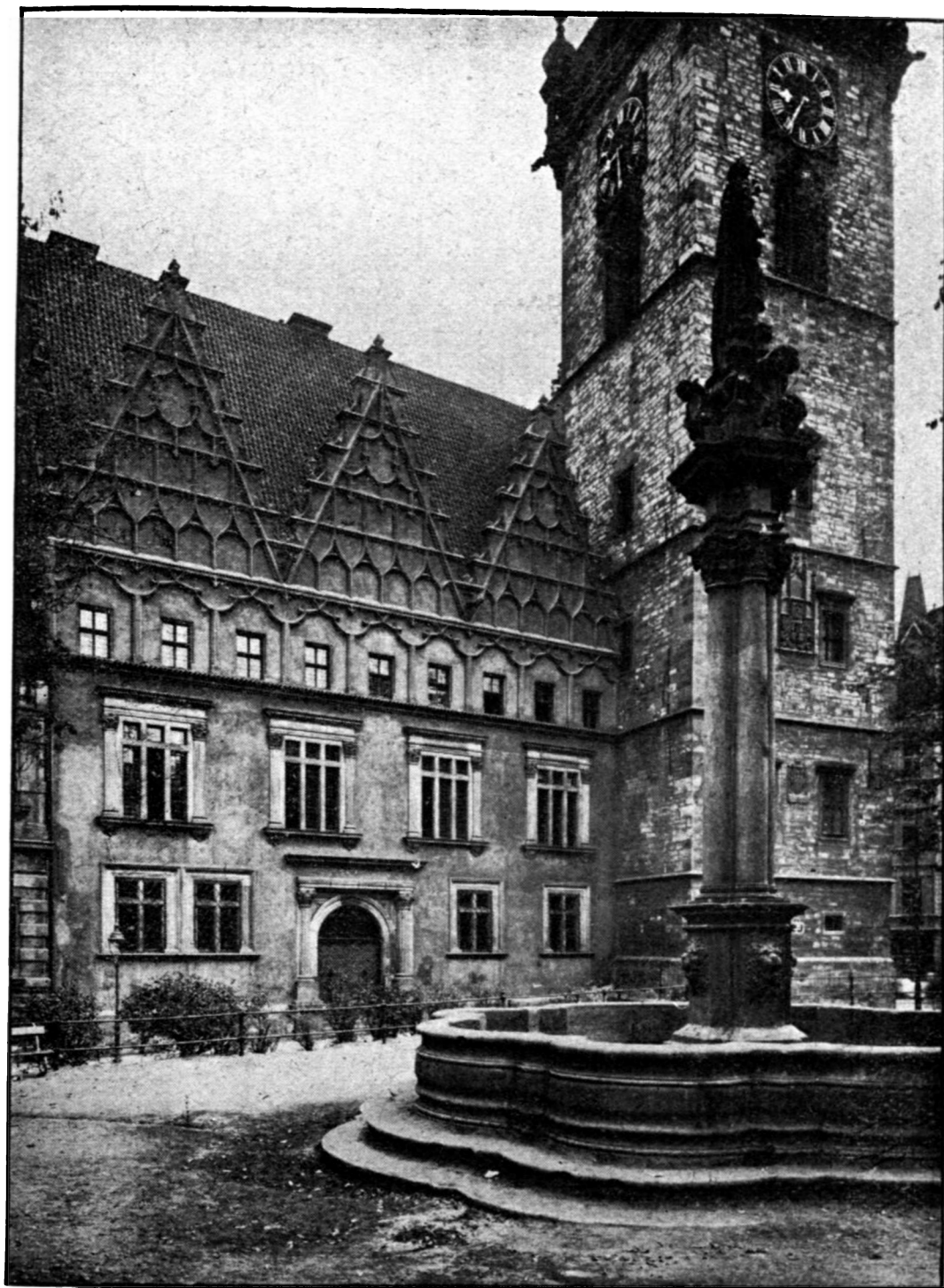
Novoměstská radnice s věží.
