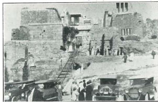
Fot. Jos. Števek. Naš výstup na Akropolis. 23.-8. 1928.
