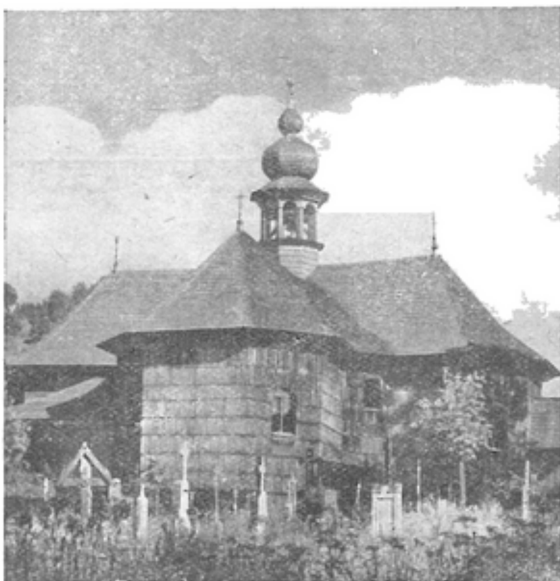
Kostel ve Velkých Karlovicích je zasvěcen P. Marii Sněžné. Je celý ze dřeva a zvenku obit šindelem. Byl vystavěn r. 1754 v podobě řeckého rovnoramenného kříže s malou věží uprostřed.
