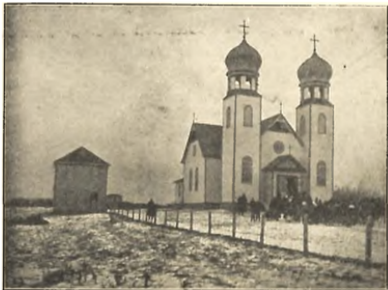
Kostel a dům OO. Redemptoristů východ. obřadu v Ituna, v provincii Saskatchewan (Kanada).
